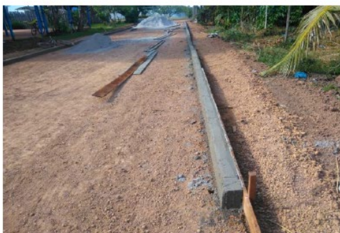
FOTO 08 EXECUÇÃO DE MEIO FIO.
