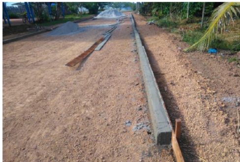
FOTO 08 EXECUÇÃO DE MEIO FIO.
