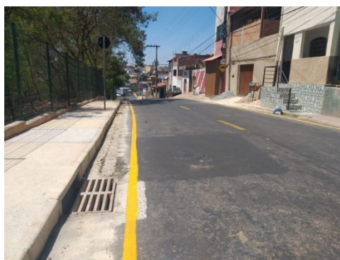
Figura 1 - Fotografia de via pública evidenciando uma boca-de-lobo para drenagem pluvial.
